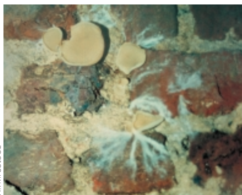
Afb. 13 Witte zwamdraden die samensmelten om het bruine vruchtlichaam van een bekerzwam te vormen.
