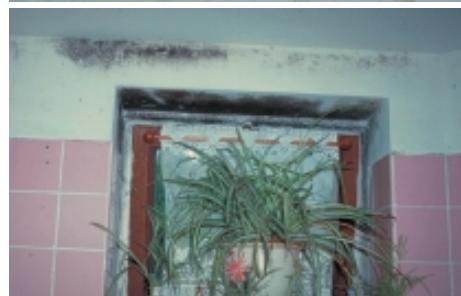
Afb. 18 Kolonies van Cladosporium sphaerospermum ter hoogte van een badkamer-venster.
