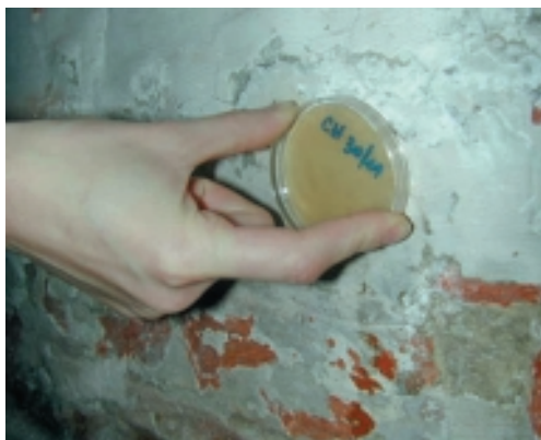
Afb. 30 Plaatsing van het RODAC-doosje op de beschimmelde of verdachte zone.
